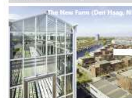
Nicht-bodengebundener Anbau während Rekultivierung
