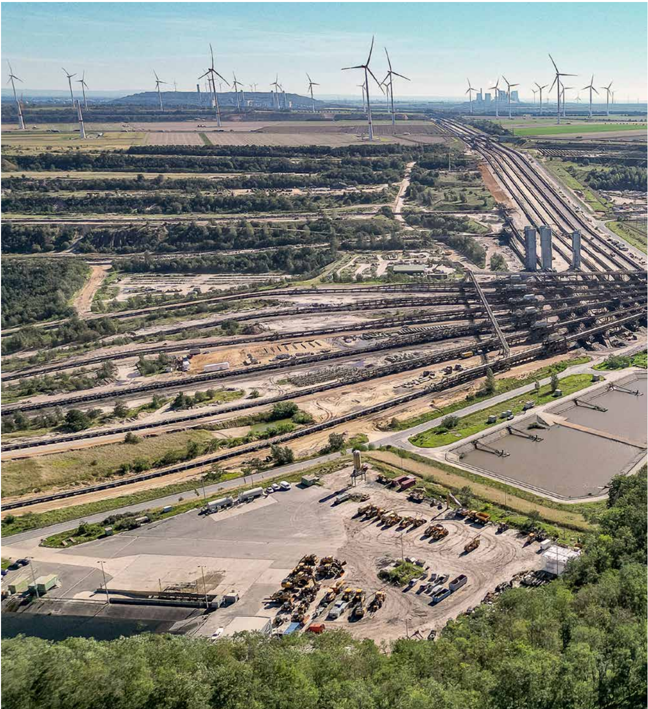
Bandtrasse zwischen Tagebau und Kraftwerk Frimmersdorf © Zweckverband LANDFOLGE
