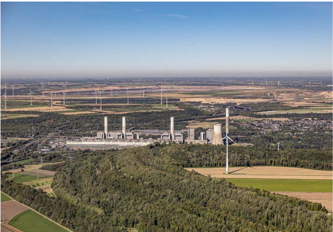
Vollrath Höhe mit Blick auf das Kraftwerk Frimmersdorf © Zweckverband LANDFOLGE
