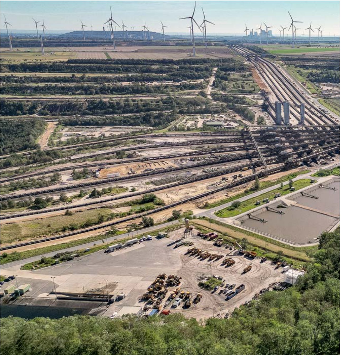
Bandtrasse zwischen Tagebau und Kraftwerk Frimmersdorf © Zweckverband LANDFOLGE
