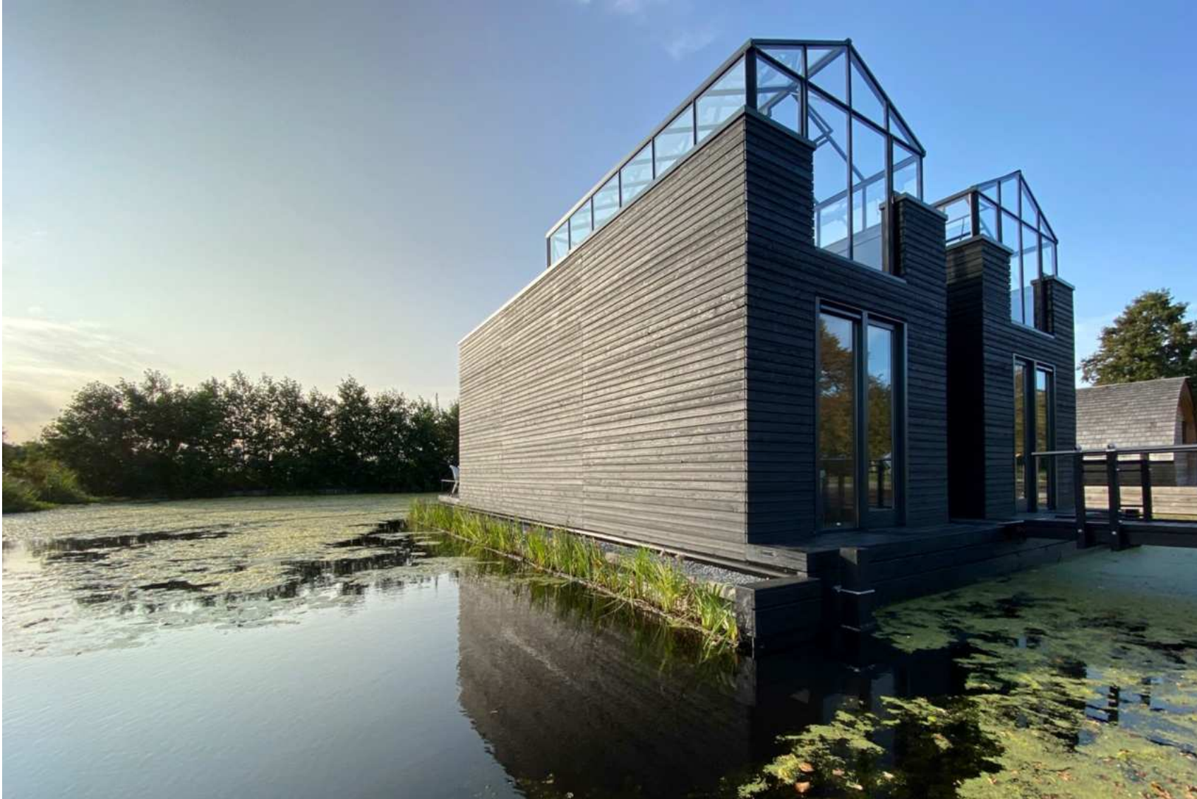
Schwimmende Häuser Siedlung Amsterdam Quelle: Waterstudio
