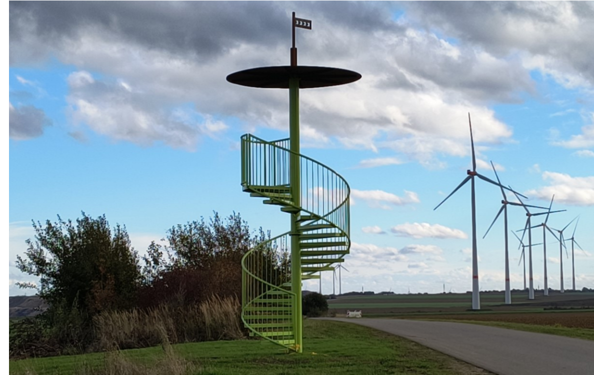
Fertigstellung Aussichtspunkt Weg 100 am 19.09.2025
