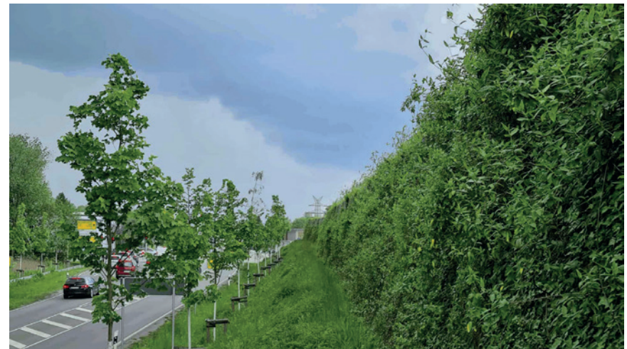
Abb. 36: Lärmschutzwand. Quelle: rau.de
