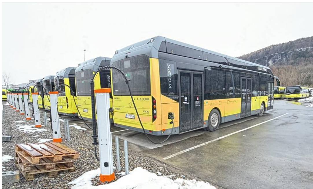
Abbildung 7 Busladestation (im Bau), Foto Wagner
