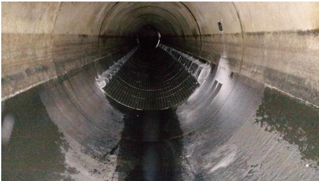
Abbildung 28 Abwasserwärmetauscher [UHRIG, 2024]
