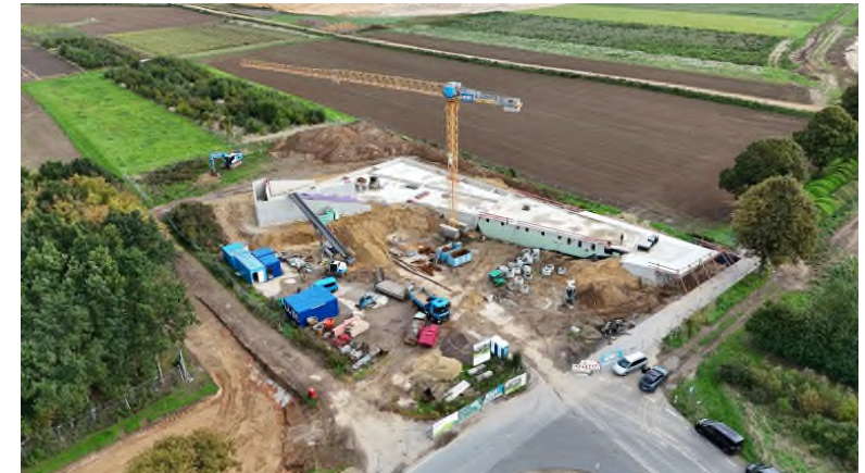
Fotos der Baustelle vom 21.09.2026
